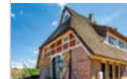
Sanierung und Umbau
