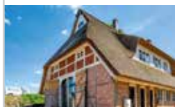
Sanierung und Umbau
